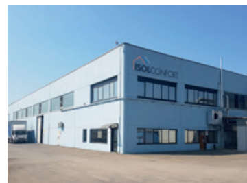
Unità produttiva 3: Pozzolo Formigaro (Alessandria)
